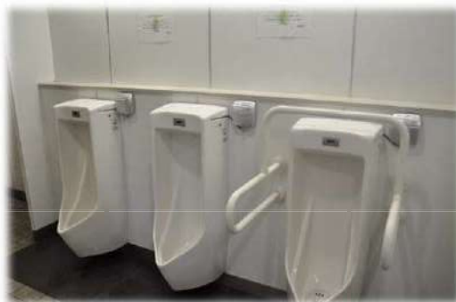
駅舎トイレ： 便器清掃後を噴霧。
